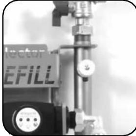
Druck durch Öffnen des Probeventils entlassen.
